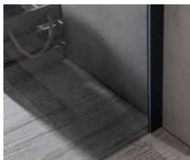
Napojení skla do přístěného profilu
